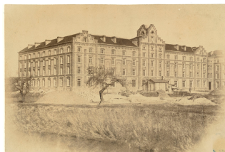
Le pavillon central en chantier
