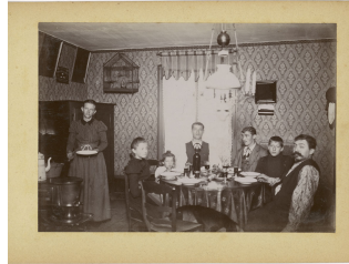
La cuisine d'un logement au troisième étage de l'aile droite du Palais social
