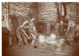
Moulage d'une baignoire dans la fonderie de l'usine du Familistère de Guise
