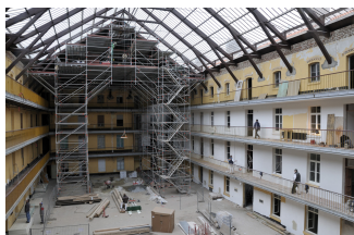
Chantier du pavillon central. Photographie Familistère de Guise, 2009
