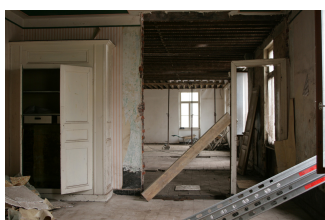
Le séchoir de la buanderie-piscine. Photographie Hugues Fontaine, 2009.
