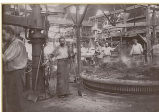
Déballage du sable des moules sur une batterie de moulage mécanique de la fonderie de l'usine du Familistère.
