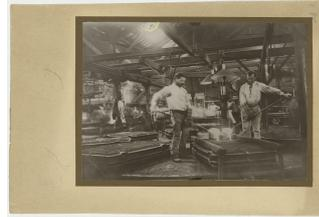
Opération de moulage sur une batterie de moulage mécanique de la fonderie de l'usine du Familistère
