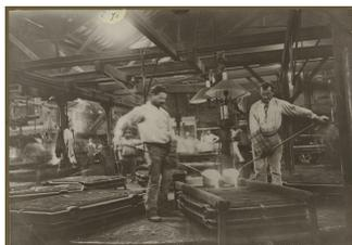
Opération de moulage sur une batterie de moulage mécanique de la fonderie de l'usine du Familistère.
