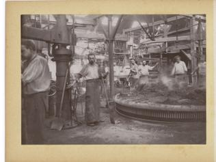
Déballage du sable des moules sur une batterie de moulage mécanique de la fonderie de l'usine du Familistère
