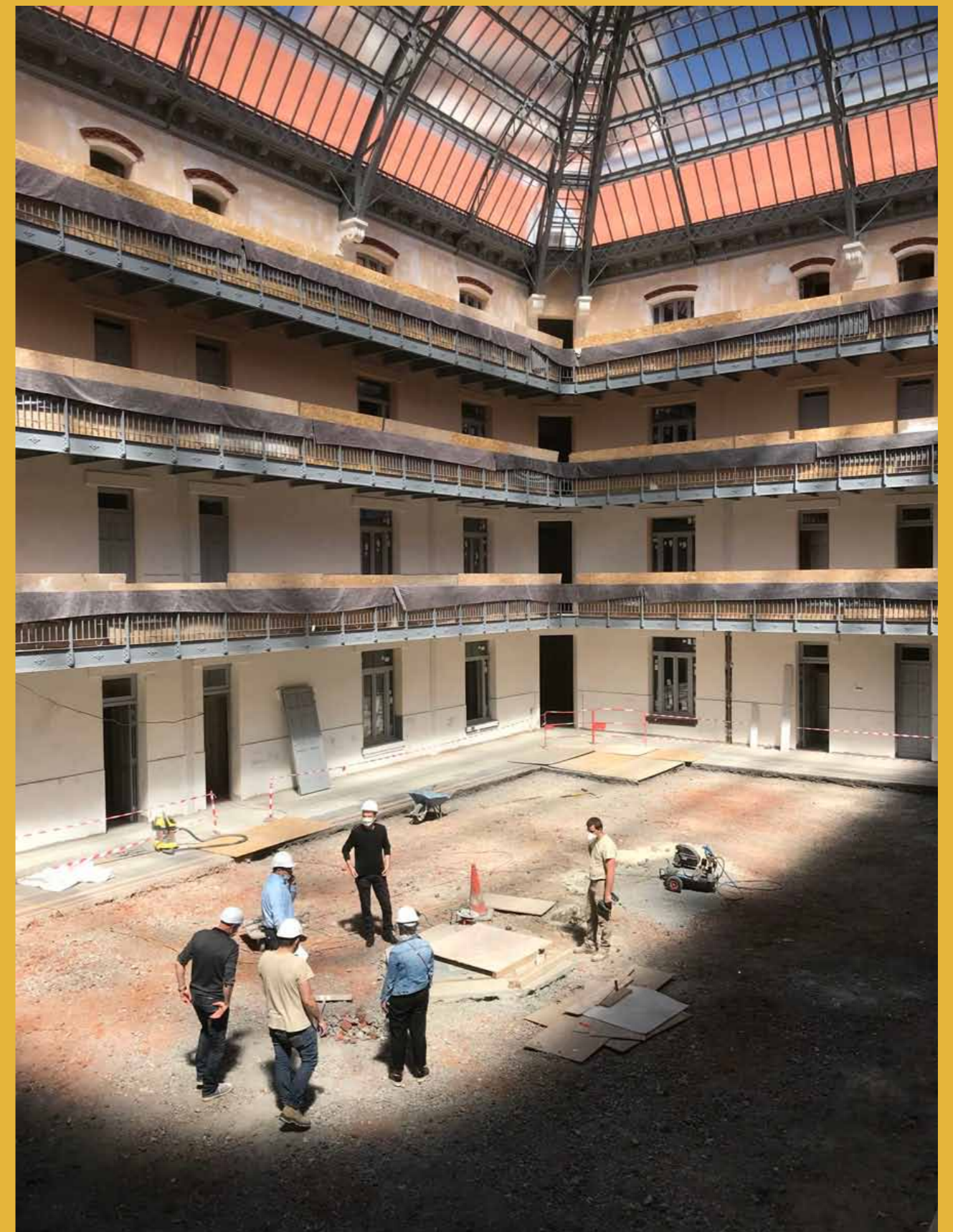
Ci-dessus et ci-contre : reprise du chantier de restauration de l'aile gauche du Familistère le 6 mai 2020.
