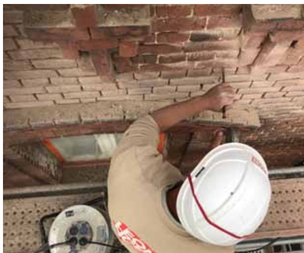
Restauration des joints de façade. Novembre 2022
