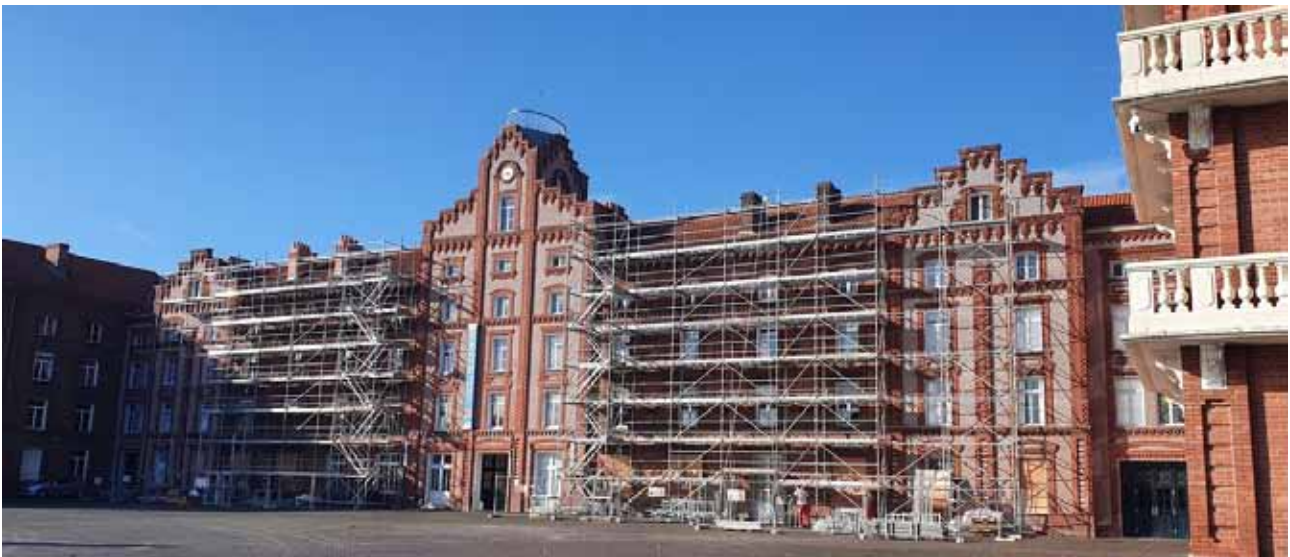
Installation des échafaudages sur la façade sud du pavillon central. Octobre 2022
