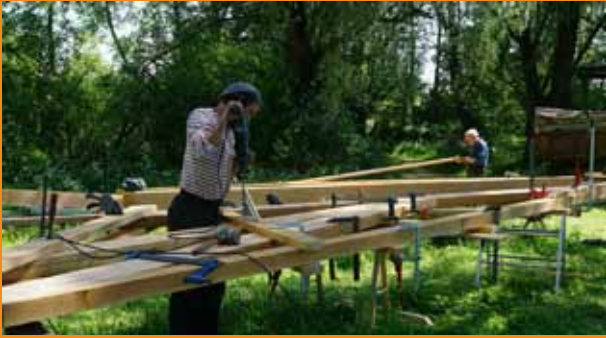
Assemblage d'une ferme de la charpente de Debout, toujours , mai 2022
