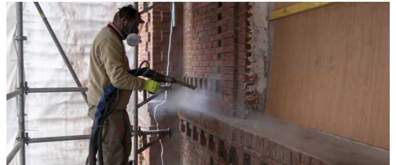
L'opération de nettoyage par cryogénie aura duré 3 semaines.
