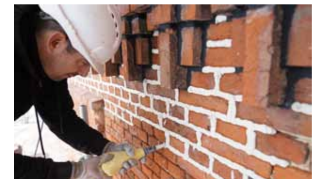
Jointoiement de la façade
