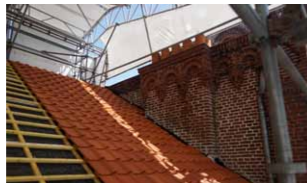
Pose de la couverture.
