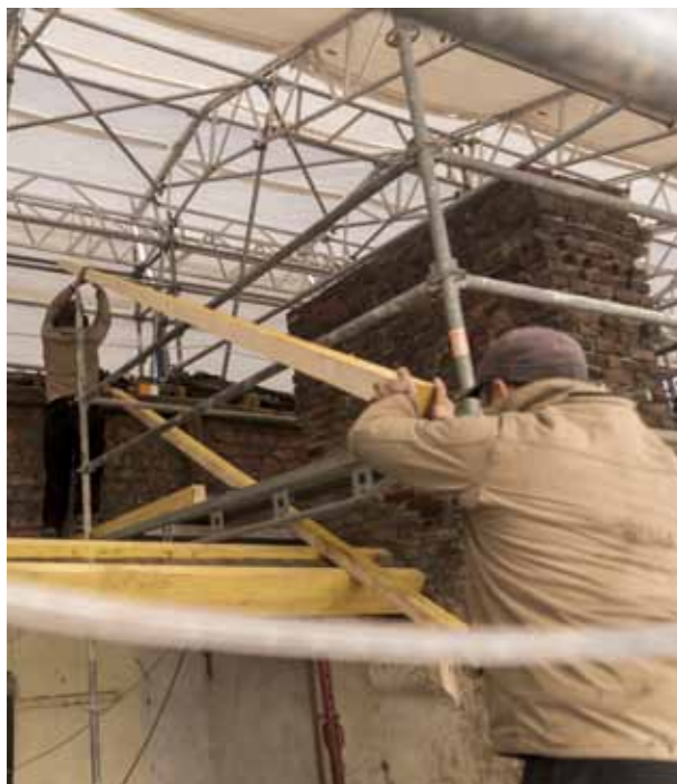
Remplacement et réhausse des chevrons.
