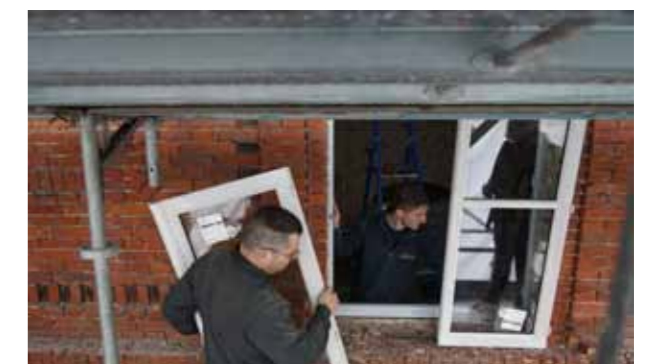
Remplacement d'une partie des fenêtres
