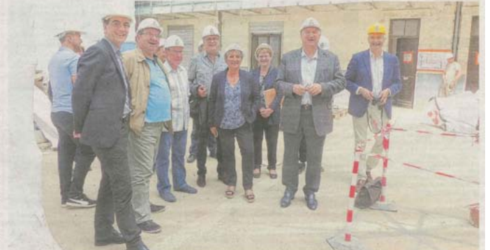
Le conseil d'administration a validé le choix du promoteur et a fait le point sur le chantier de l'aile gauche, lieu du futur hôtel.
